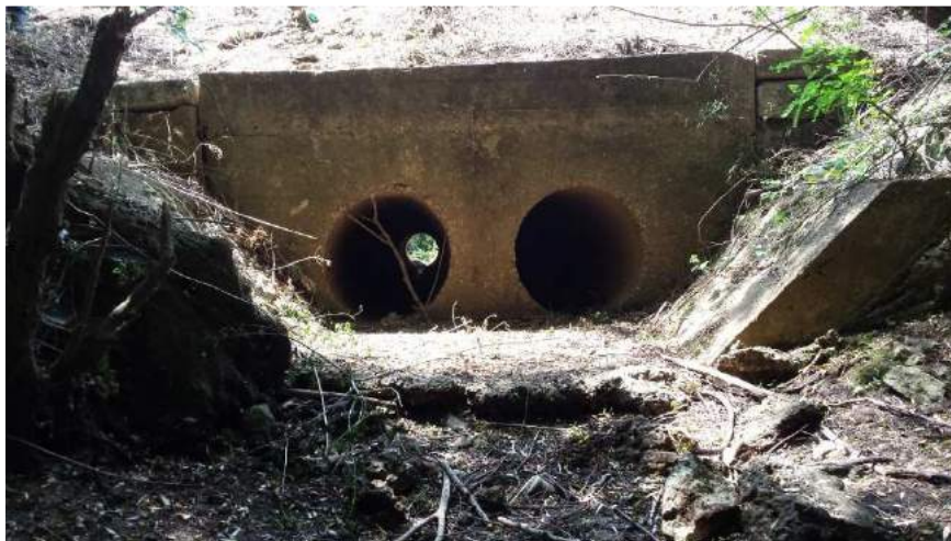
Slika 2.11 Sjeverna strana propusta (Izvor: Idejni projekt)
